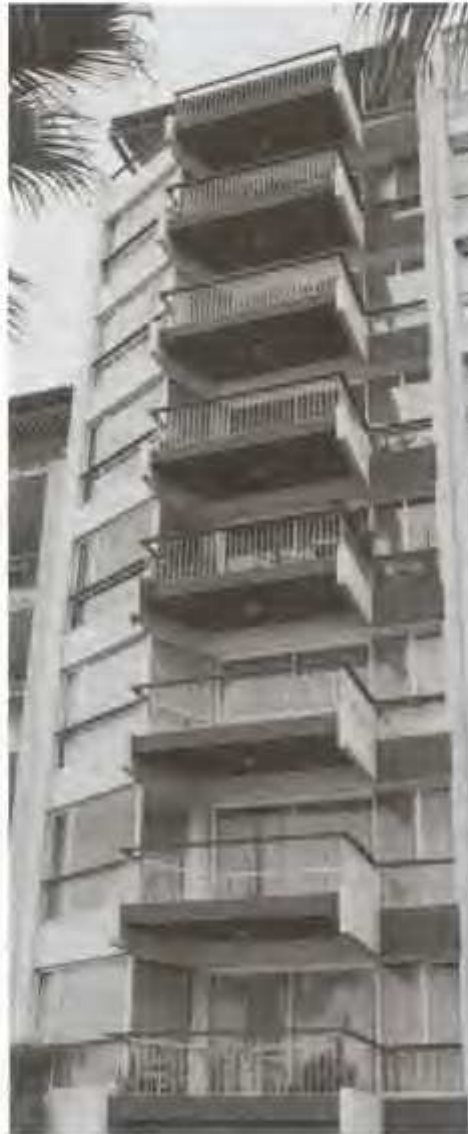
İpek apartmanı görünüş
