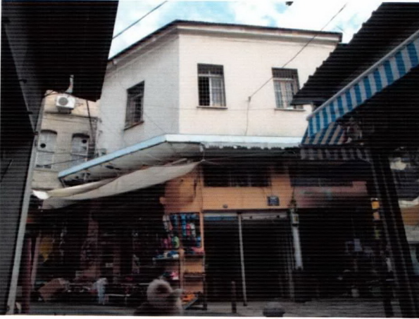
Resim 26. 927 sokakta yer alan yapı
