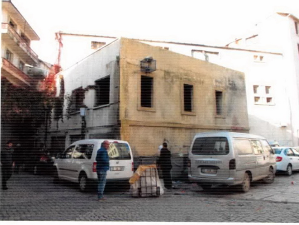
Resim 25. 920 sokakta yer alan yapı
